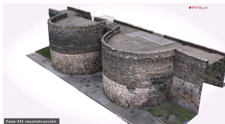
Figura 1: Reconstrucción virtual de la muralla de Lugo mediante MetaShape. Tomada de: Imasgal, “PROYECTO MURALLA DE LUGO 2015. Imasgal Técnica
