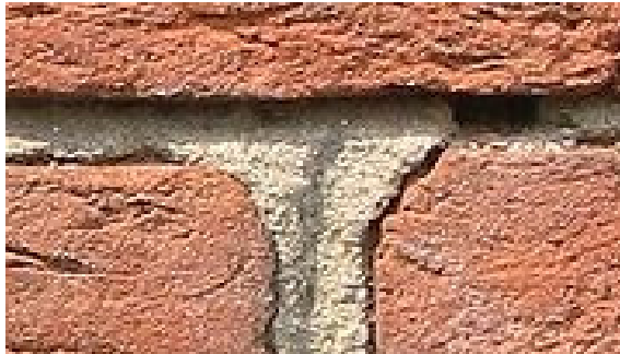
Figura No. 4 Mortero entre hiladas de ladrillo para rellenar juntas.
