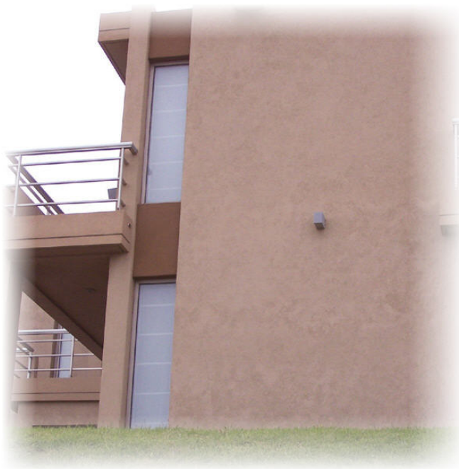
Figura No. 2 Revoque para exteriores
