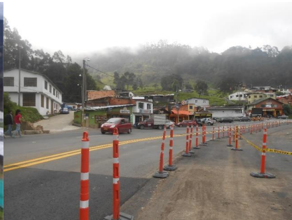
Fotografía 2. Vista Tramo 4B, Inspección El Vino
