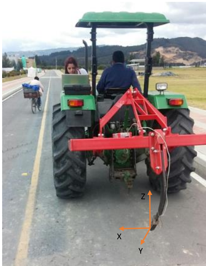
Ilustración 73. Arado tipo cincel elevado de la superficie.
