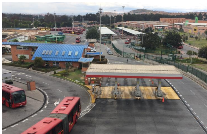
Figura 3 Zona de Tanqueo
