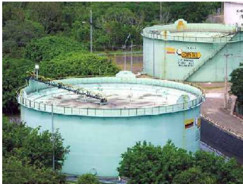
Foto 2. Tanque de techo flotante. Fuente: Ecopetrol web
