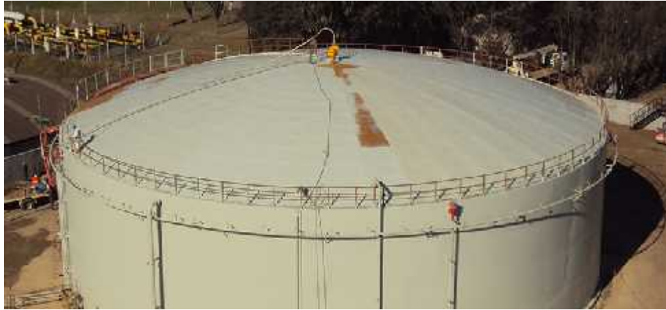
Foto 1. Tanque de techo fijo.
