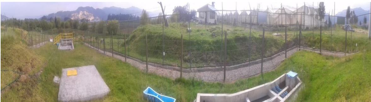
Figura 1. Vista panorámica desde el punto de entrada a la PTAR
