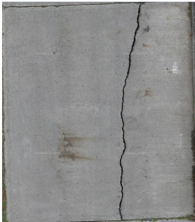
Fotografía 3. Grieta longitudinal
