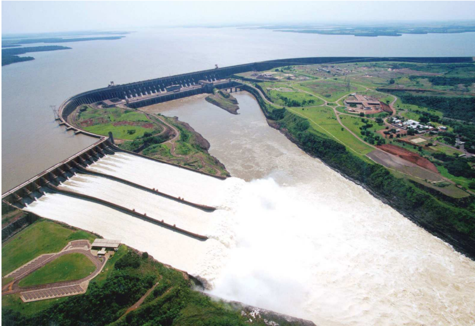
Figura No. 9 – Central Hidroeléctrica de Itaipú en el Río Paraná, frontera Brasil-Paraguay
